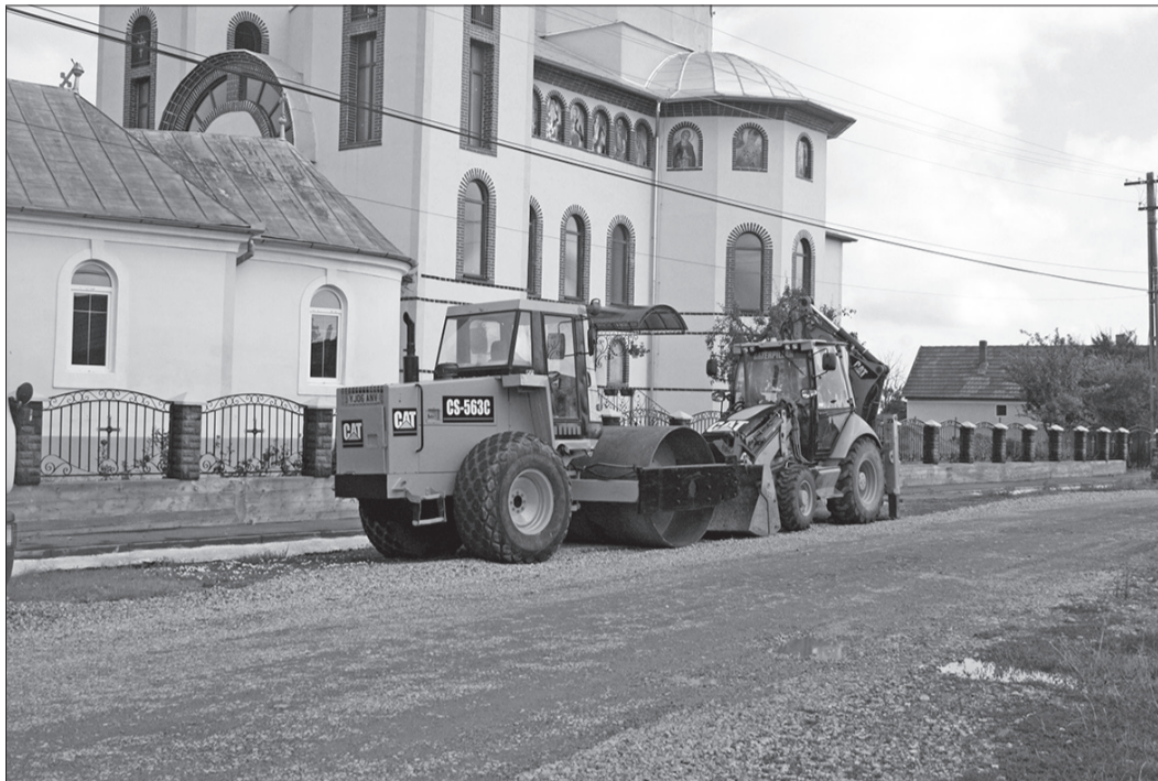
În comună se derulează lucrări de asfaltare a străzilor
