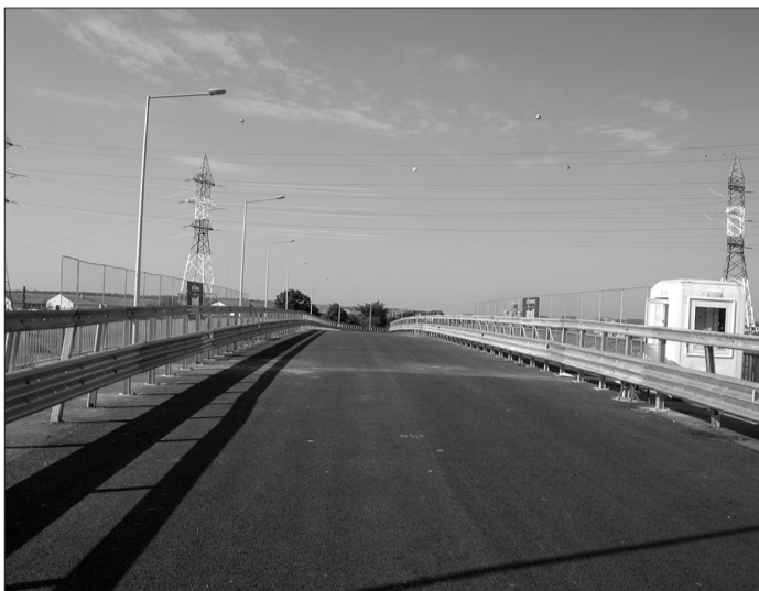
Ministrul Transporturilor Sorin Bușe a vizitat șantierul de pe centura Oradiei
